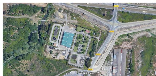
Foto 17: Vista planta nueva EDAR San Roque. Fuente: https://www.miteco.gob.es
