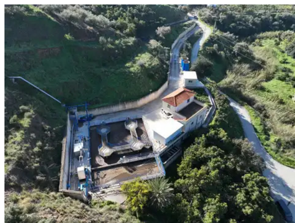
Foto 46: EDAR Frigiliana. Fuente: https://www.malaga.es
