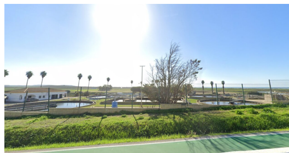
Foto 62: EDAR de Conil de la Frontera. Fuente: https://www.andaluciainformacion.es
