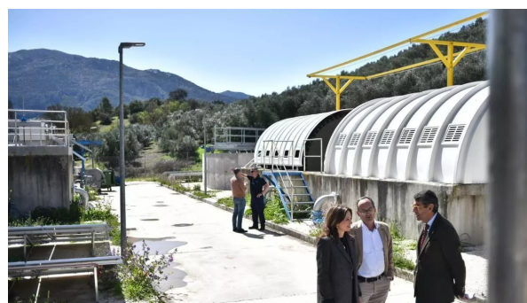
Foto 50: Remodelación EDAR Villanueva del Rosario. Fuente: https://www.laopiniondemalaga.es
