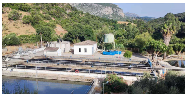
Foto 18: EDAR de Ubrique. Autor: EeA Sierra de Cádiz
