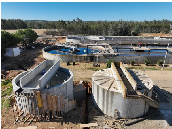
Foto 34: Adecuación EDAR de Moguer, Palma del Condado, Beas, San Juan del Puerto y Trigueros. Fuente: https://www.acuaes.com
