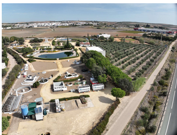
Foto 54: Vista de las instalaciones de la EDAR de Carrión de los Céspedes. Fuente: https://natmed-project.eu
