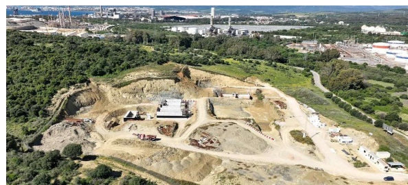
Foto 15: Obras de la nueva EDAR de Los Barrios. Fuente: https://www.europasur.es
