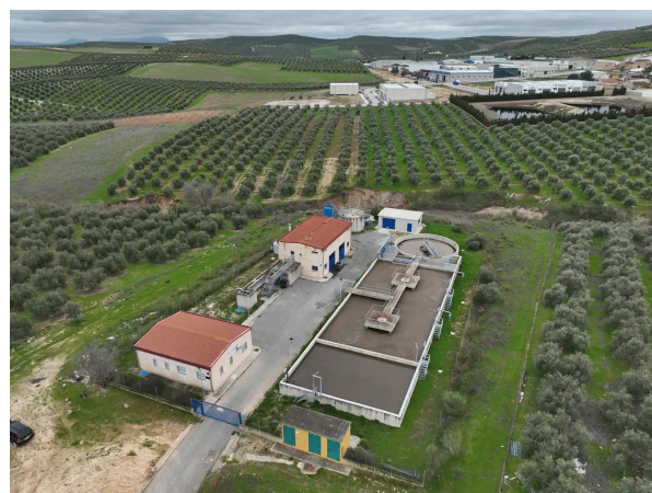
Foto 38: EDAR de Alameda. Fuente: https://www.malaga.es
