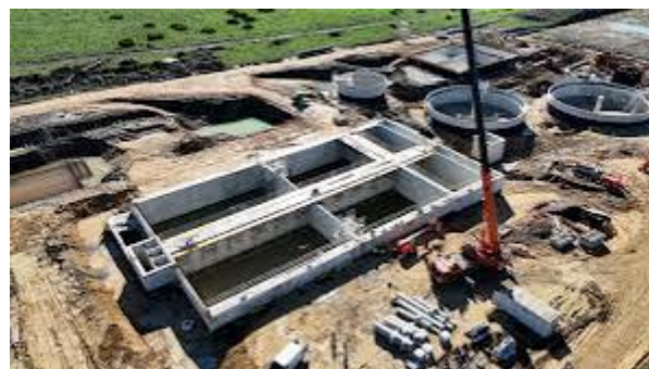
Foto 11: Avance obras EDAR Barbate. Fuente: https://grupoazvinews.com
