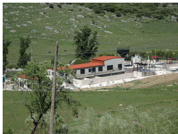
Foto 13: Obras de la nueva EDAR de Grazalema. Autor: Ecologistas en Acción Sierra de Cádiz
