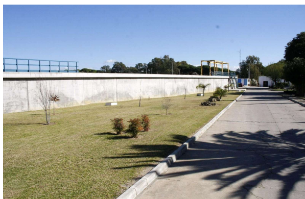
Foto 14: Interior de la EDAR Las Galeras (El Puerto de Santa María).
