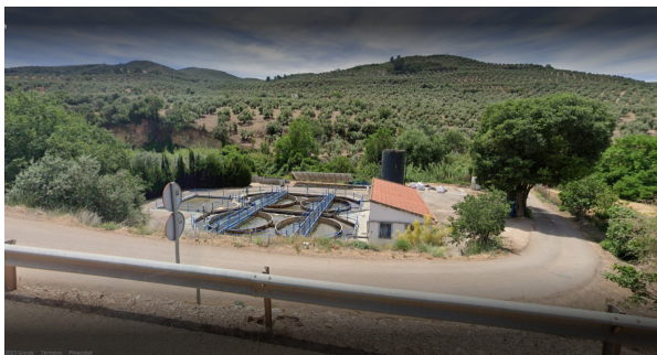
Foto 35: EDAR de Beas de Segura. Fuente: Google Maps
