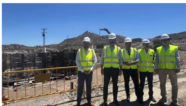
Foto 10: Visita del Consejero a las obras de la EDAR de Tabernas.
