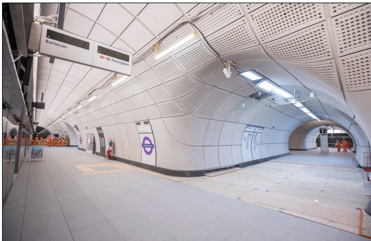
Ilustración 21. Geometrías curvas en los túneles de las estaciones de la Elizabeth Line. Podría servir de inspiración y aplicarse puntualmente en el tramo sur, exclusivamente para las estaciones más saturadas, como, por ejemplo, la estación de Heliópolis, que daría servicio al estadio Benito Villamarín.
