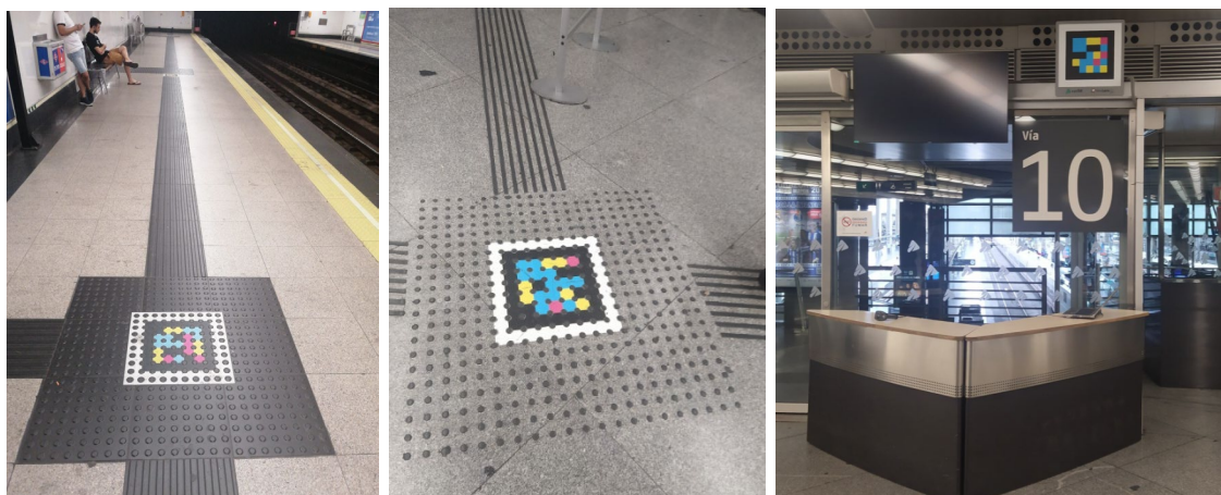
Ilustración 91. Codificación Navilens integrada en el pavimento podotáctil de estación de metro de Madrid (31a) y estación de Atocha (31by c). Fuente: Asociación Eliminando Barreras.
