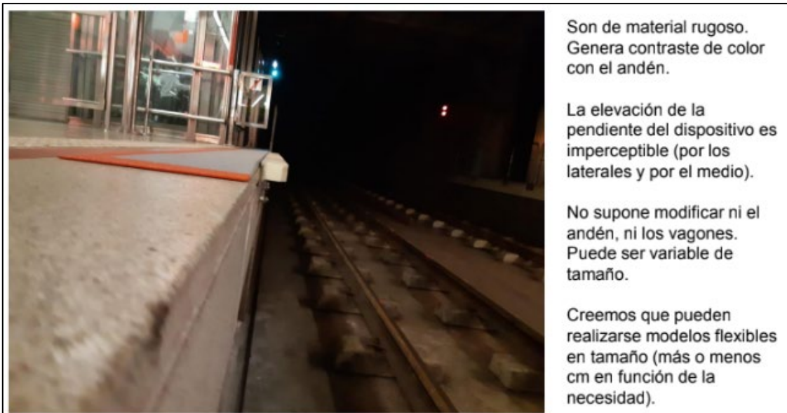
Ilustración 81. Despliegue de rampa en Max Train (EEUU), de forma similar a Tussam.
