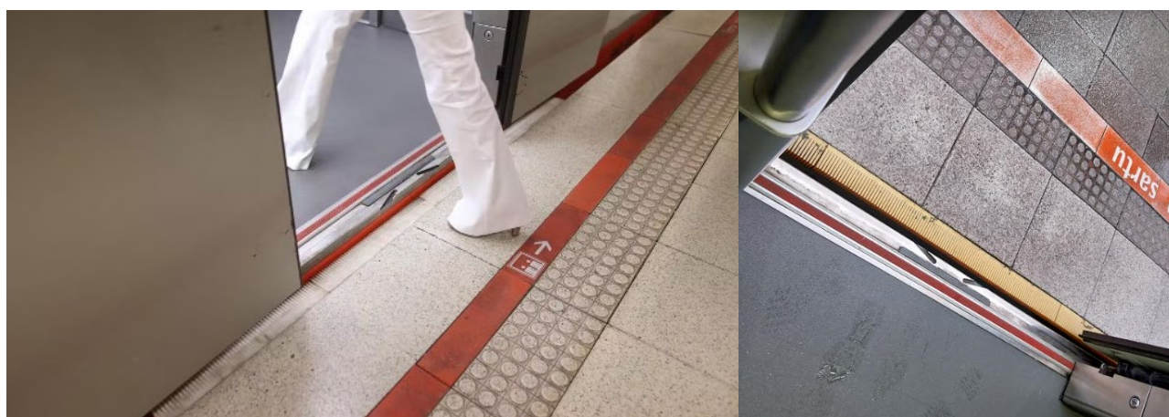
Ilustración 79. Sistema GAP Filler instalado en otras geografías. Fuente: Asociación Eliminando Barreras.
