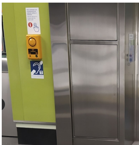
Ilustración 92. Bucle magnético para posición en «T» en Metro de Madrid. Fuente: Asociación Eliminando Barreras.
