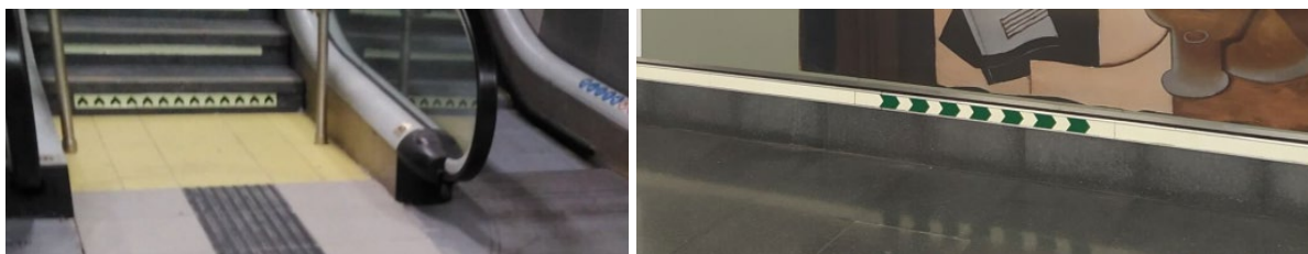
Ilustración 89. Detalle de flechas insertadas en zonas de inicio de escalera para señalar el sentido de estas así como orientación de salida / salida de emergencia en bandas luminosas sobre los rodapiés de la zona de andenes, facilitando la orientación de salida al salir de los vagones como un elemento adicional. Fuente: Asociación Eliminando Barreras.
