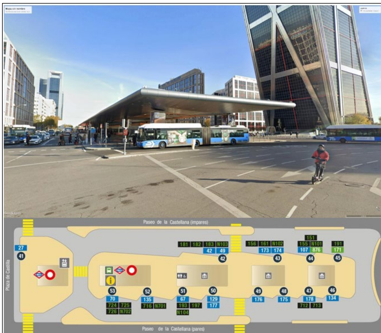
Ilustración 19. Intercambiador superficial existente en Plaza Castilla, justo en la mediana del Paseo de la Castellana. Tiene un acceso directo al metro, lo que multiplica la intermodalidad, y, por tanto, la demanda. Se puede tomar de referencia para diseñar un intercambiador superficial entre metro y buses (urbanos y metropolitanos) frente al Estadio Benito Villamarín.
