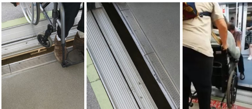
Ilustración 78. Imágenes de la parada de Puerta de Jerez. Se observa un desnivel considerable y peligroso para acceder o bajar del vagón “accesible”. Fuente: Asociación Eliminando Barreras (11/2022).
